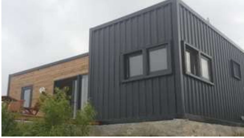
Resim 41 Boyalı fırın kuru ahşap ve boyalı trapez cephe ( kombine )
