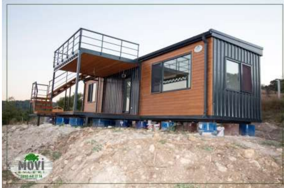
Resim 40 Boyalı fırın kurusu ahŐap ve boyalı trapez cephe ( kombine )
