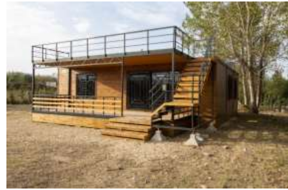
Resim 57-58 Prekast temel sistemi, alt veranda, üst teras, terasa çıkış merdiveni, temel alt kapama
