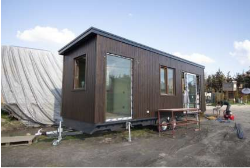
Resim 43 Fırın kuru ahşap cephe ( dikey döşeme )
