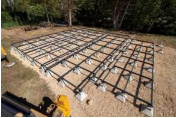
Resim 57-58 Prekast temel sistemi, alt veranda, üst teras, terasa çıkış merdiveni, temel alt kapama
