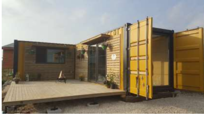
Resim 42 Yük konteyneri naturel cephe ve fırın kuru boyalı ahşap cephe ( kombine )
